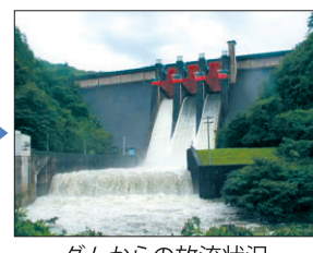
ダムからの放流状況
