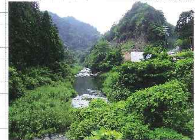
▼初瀬取水施設
