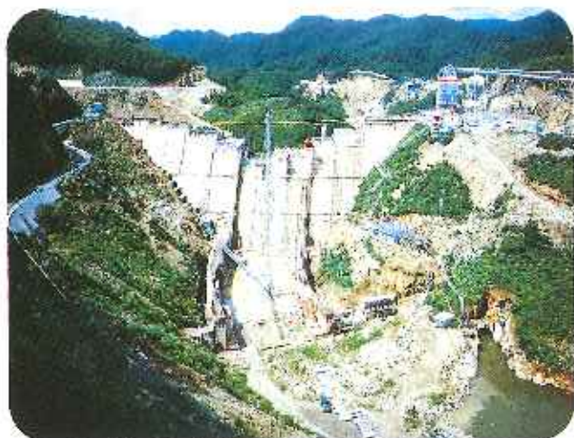
建設中の室生ダム
