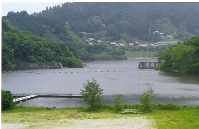
副ダム湖面と桐山さざなみ広場
