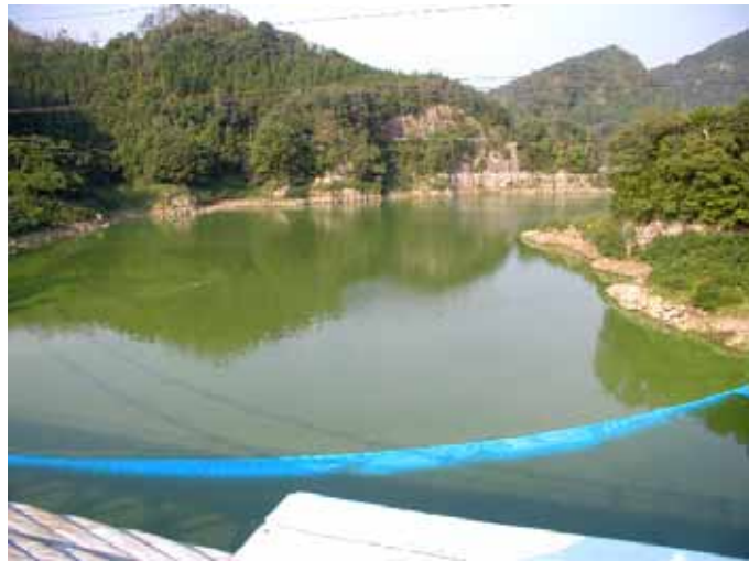
写真 - 1 拡散防止フェンス (過去の室生ダムでの実施状況)
