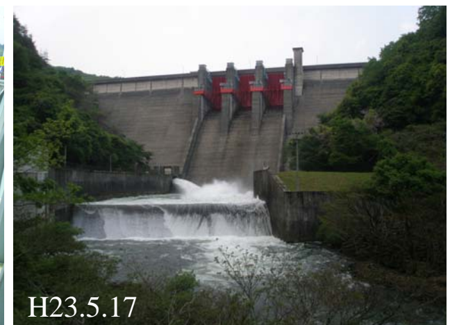
室生ダム 約13m 3 /s放流状況
