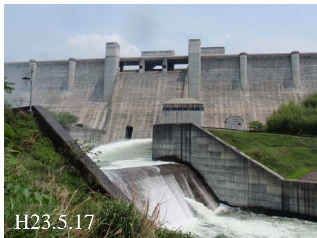
比奈知ダム 約30m 3 /s放流状況
