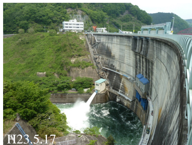
青蓮寺ダム 約30m 3 /s放流状況
