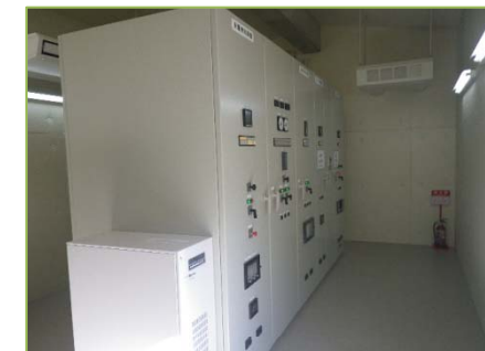
高圧受電盤 発電機制御盤
