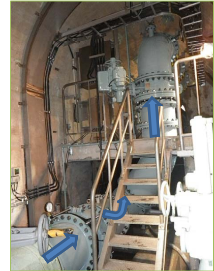
分岐管_入口弁
