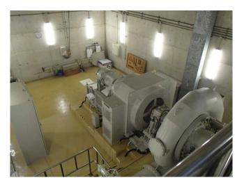
●比奈知ダム発電所の諸元 最大出力;1,800KW
