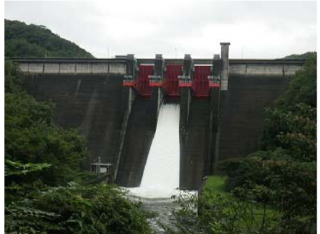
洪水放流設備（洪水吐きゲート）からの放流の状況
