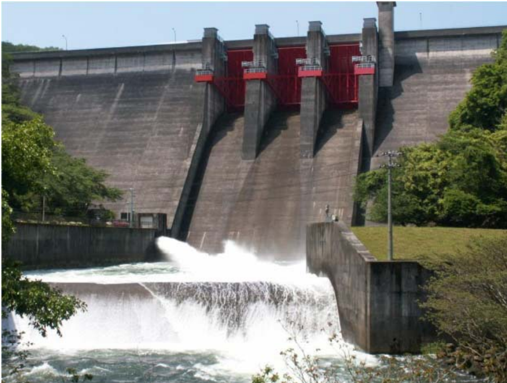
利水放流設備（バルブ）による放流（約 13\text{m}^3/\text{s} ）の状況
