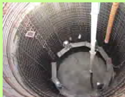
杭体コンクリートの打設状況
