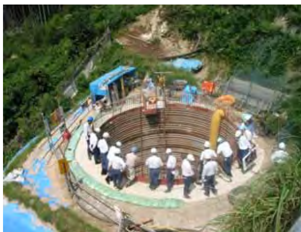
工事現場を見学する講習生
