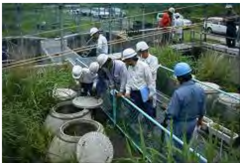
オオサンショウウオ保護池を見学する工事請負者
