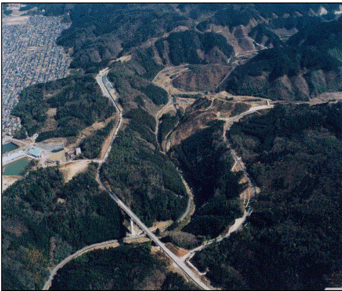
川上ダム建設予定地
