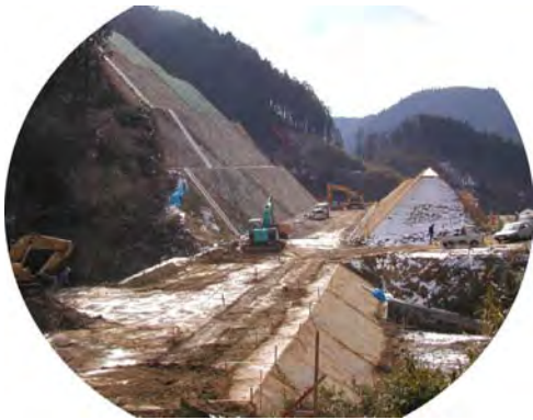
工事現場の様子
