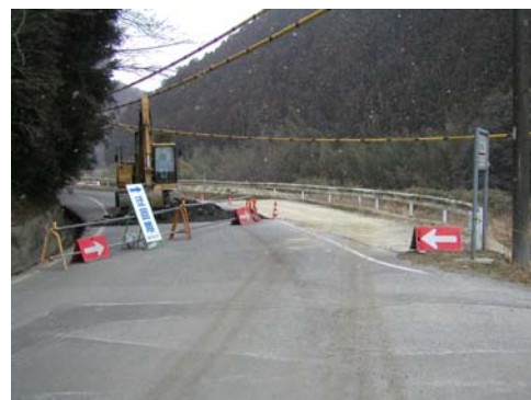
日中の現場の様子(H18.1.27撮影)
