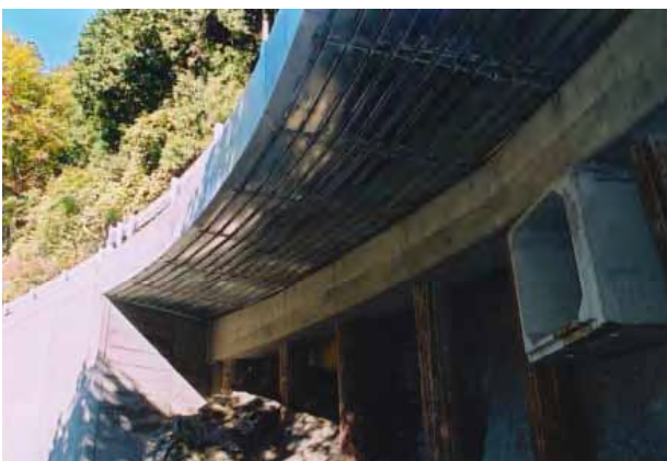
施工完了写真
