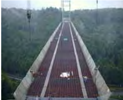
合成床版施工状況(要石大橋)
