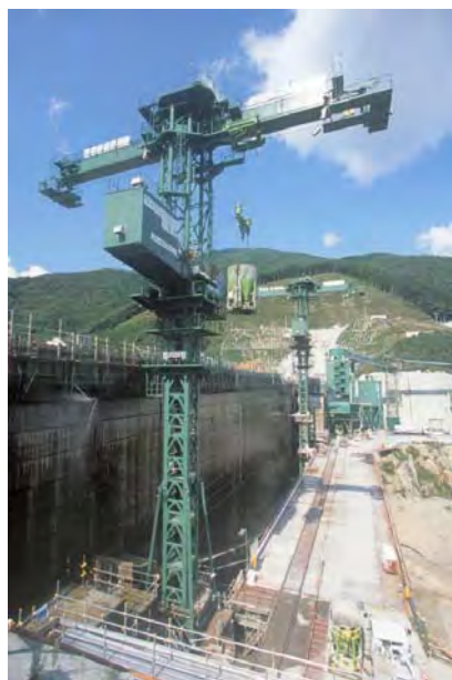
コンクリートの打設状況
