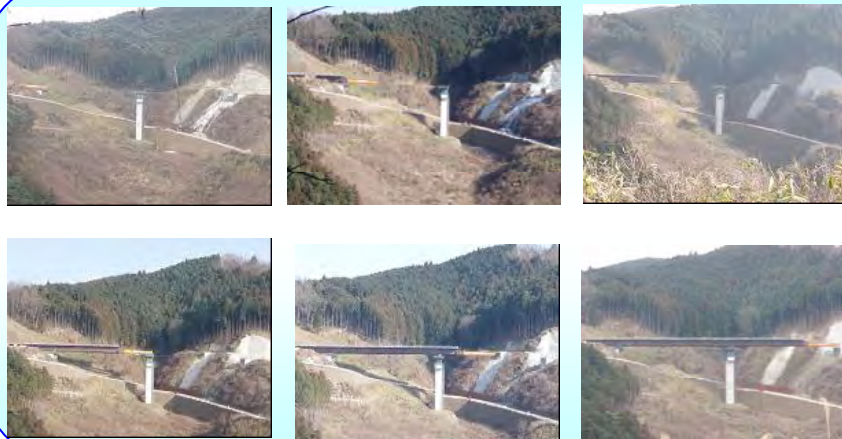
4号橋送り出し状況
