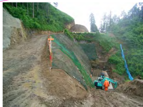
工事実施状況（H19.6.22 撮影）
