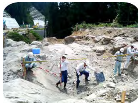
工事現場での実習生（中央左）
