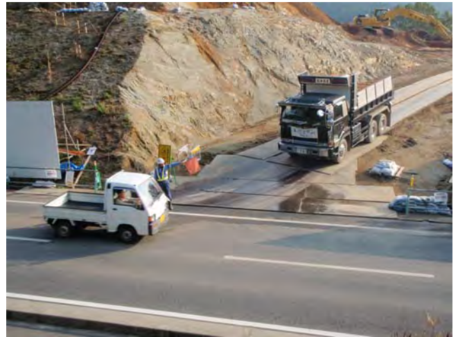
付替県道松阪青山線における一般車両の安全を確保した作業状況
