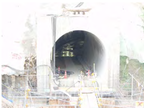
呑口部の作業状況
