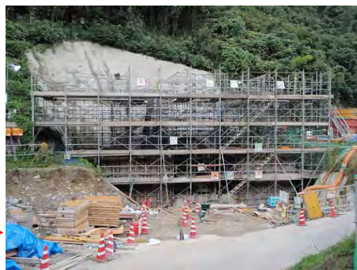
呑口部の作業状況
