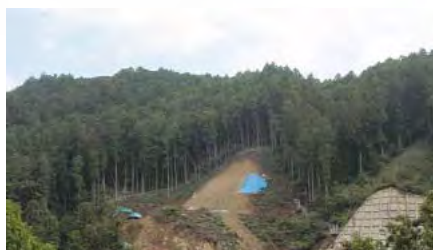
トンネル上流側の作業状況
