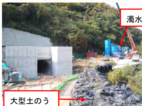
仮排水路トンネル呑口部の周辺状況
