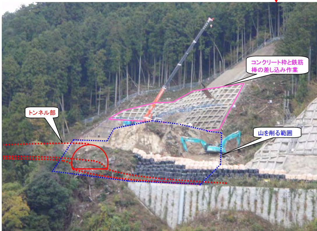
川上ダム付替県道青美線トンネル工事の状況
