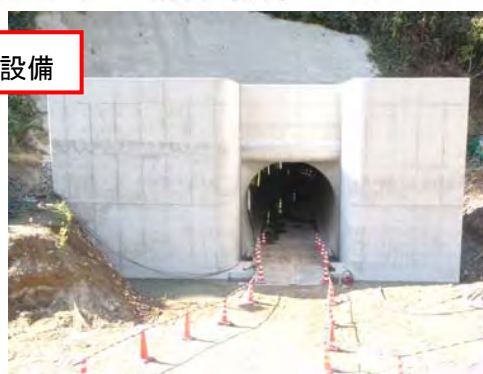
仮排水路トンネル呑口部（拡大）
