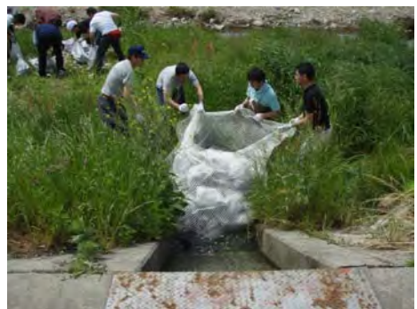
水質浄化のための木炭設置
