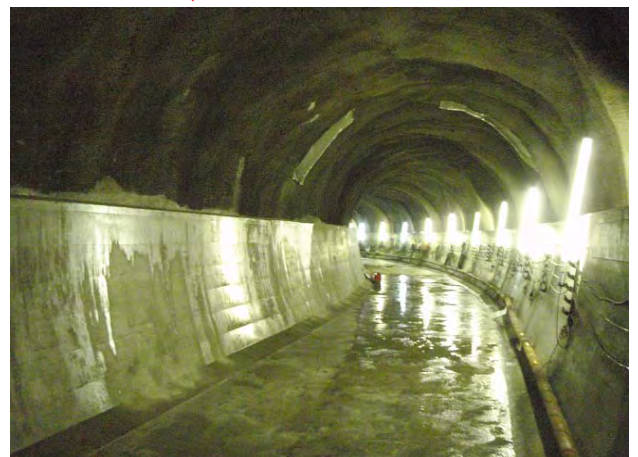
コンクリートで覆われたトンネル内部の状況
