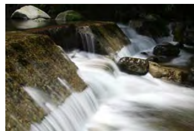
前深瀬川新田井堰
