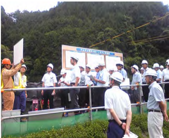
仮排水路トンネル工事現場
