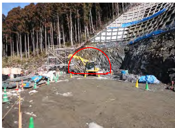
トンネル入口付近の作業状況
