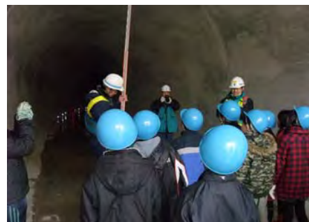
仮排水路トンネルの内部
