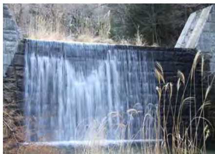
木津川最上流部の青山川に設置された青山堰堤 (昭和45年新設、平成7年嵩上)
