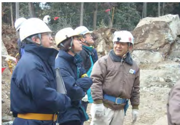
工事現場の安全パトロール
