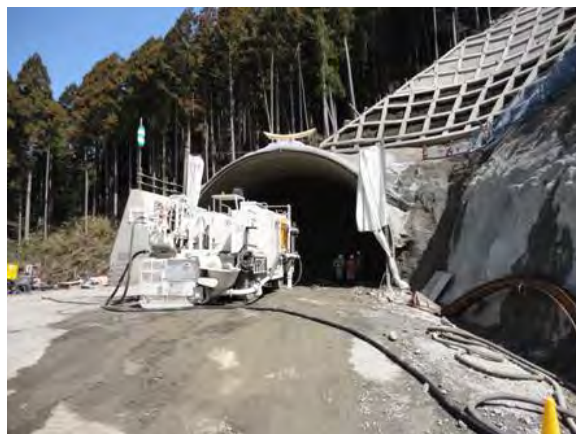
トンネルの入口
