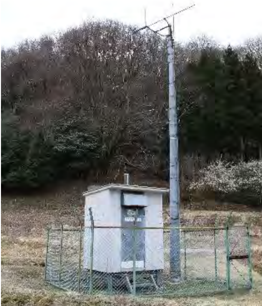
高尾にある雨量観測所
