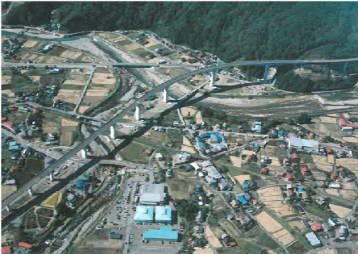
中部縦貫自動車道の長良川高架橋
