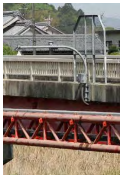
郡橋（依那古）に取り付けられている電波式水位計
