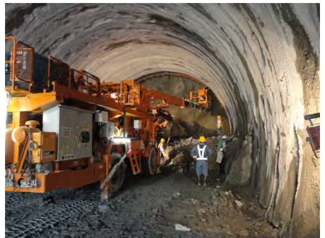
ドリルジャンボという大型機械を使って作業をしています
