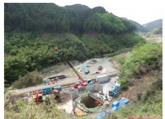
手前の穴が橋脚の基礎部分です
