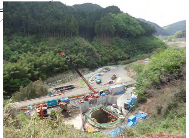
手前の穴が掘上がった橋脚の基礎です
