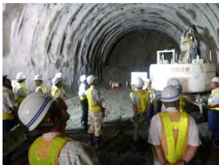
トンネル現場の見学
