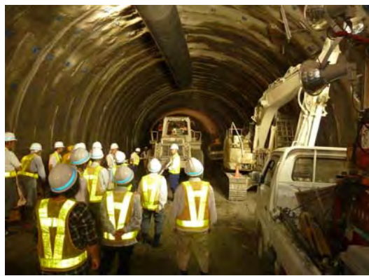
トンネル工事現場の見学
