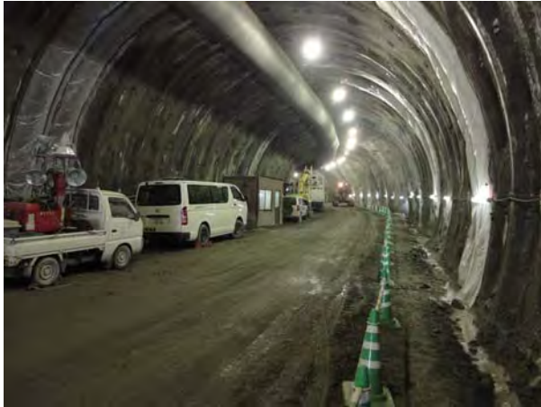
トンネル内の様子
