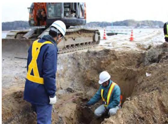
地震によるひび割れの深さを確認しながらの作業
