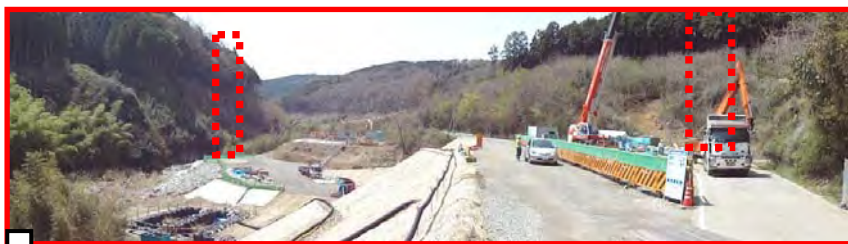
1年間の工事によりP1橋脚、P2橋脚が出現しました。
