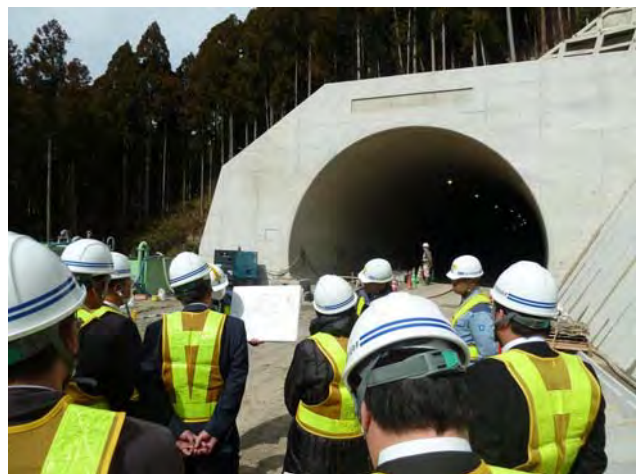
工事の進捗状況の説明
