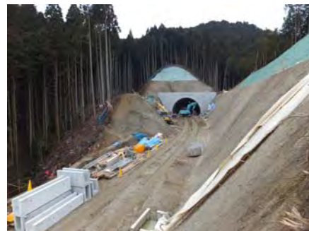
トンネル工事(平成24年3月現在)
