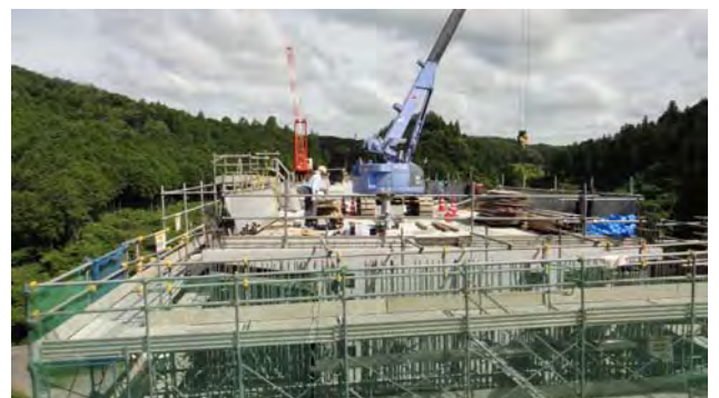
A2橋台側より青山羽根方面を望む
