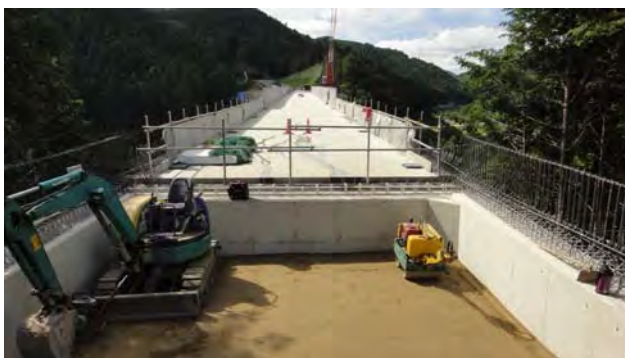
A1橋台側より種生方面を望む
