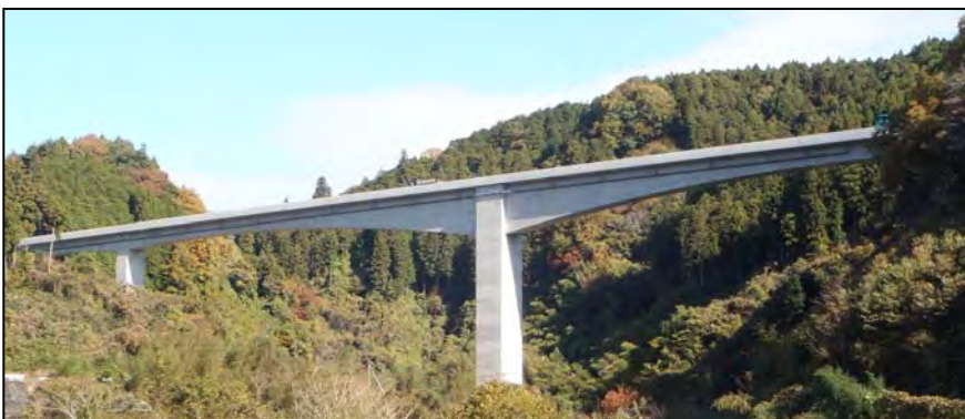
平成25年12月撮影（完成）
