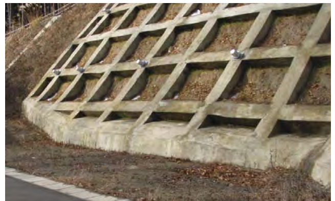
県道松阪青山線で見られるグラウンドアンカー工
