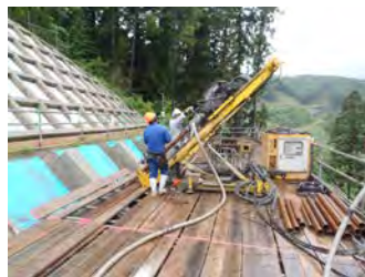
グラウンドアンカー挿入の ための削孔状況
