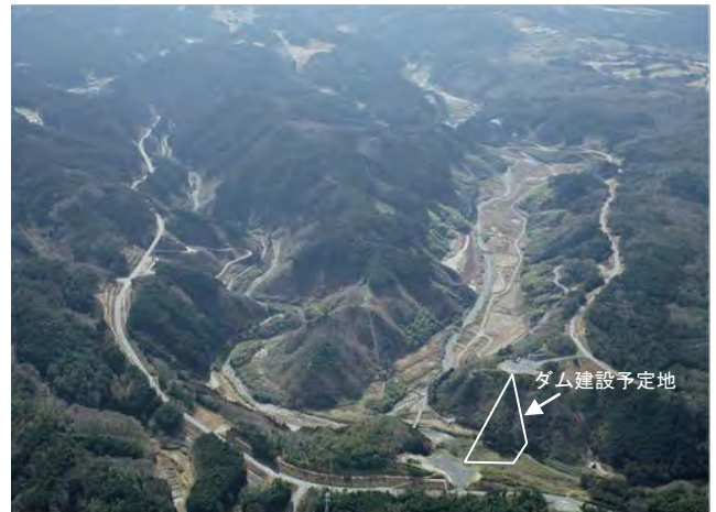
ダム建設予定地(平成24年2月撮影)
