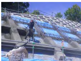
斜面に張り付き 法柵を施工する作業員
