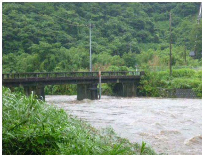
増水した前深瀬川 (9日16時頃の西の沢橋)
