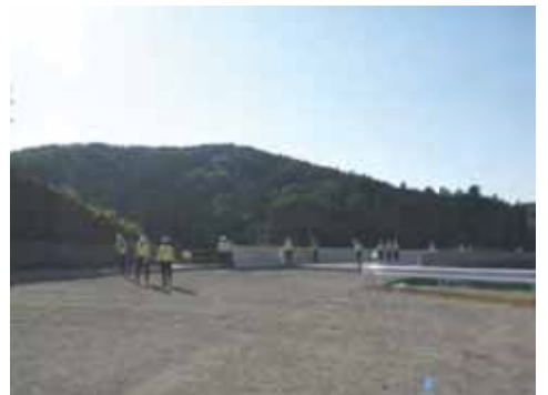
写真③ 付替県道の概成区間
