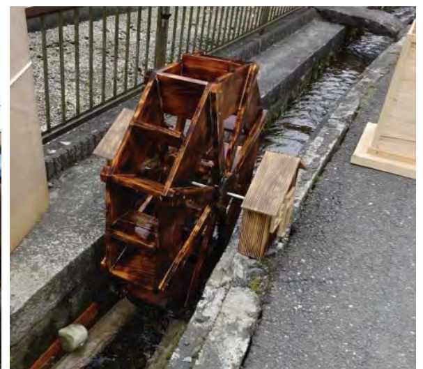
街道沿いの水路に設置した水車
