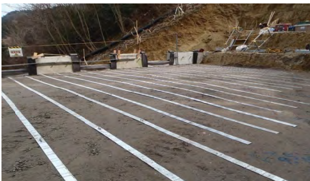
鋼鉄製の帯の設置状況
