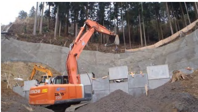
コンクリート製の壁の設置状況
