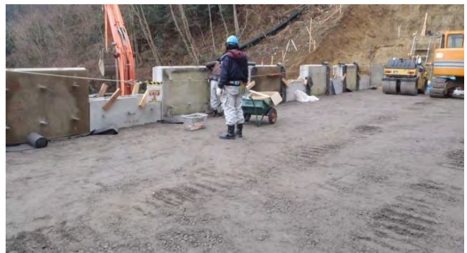
コンクリート製の壁の裏側を良質な土砂で埋める
