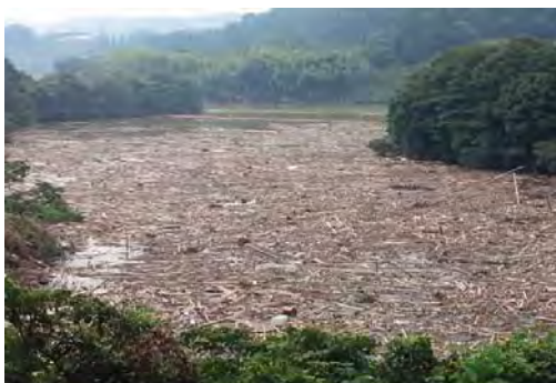
ダム湖の流木貯留と濁水
