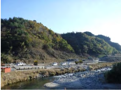
工事用道路の工事状況 (前深瀬川と川上川との合流部付近)
