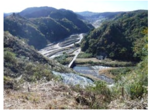
ダムサイト右岸天端広場から望む工事状況
