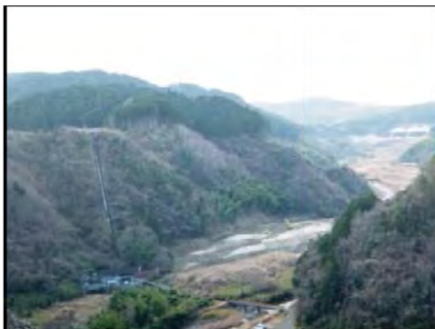
現在の発電所とその周辺
