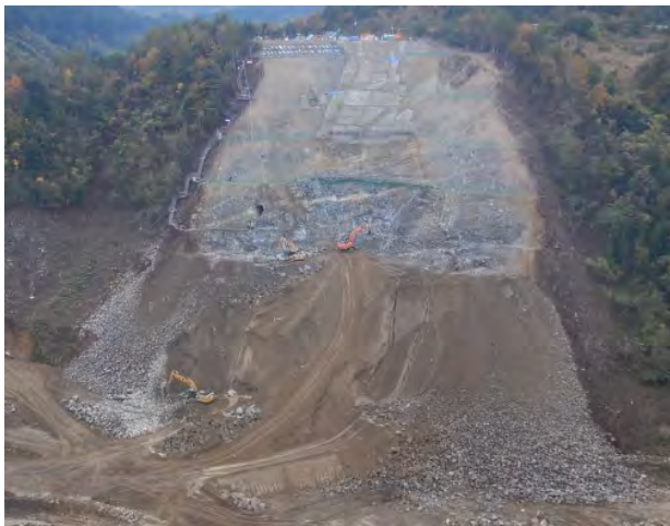
基礎掘削工事の進捗状況（左岸側）
