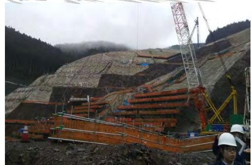
ダムサイトの施工状況
