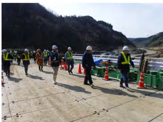
工事現場の安全パトロール
