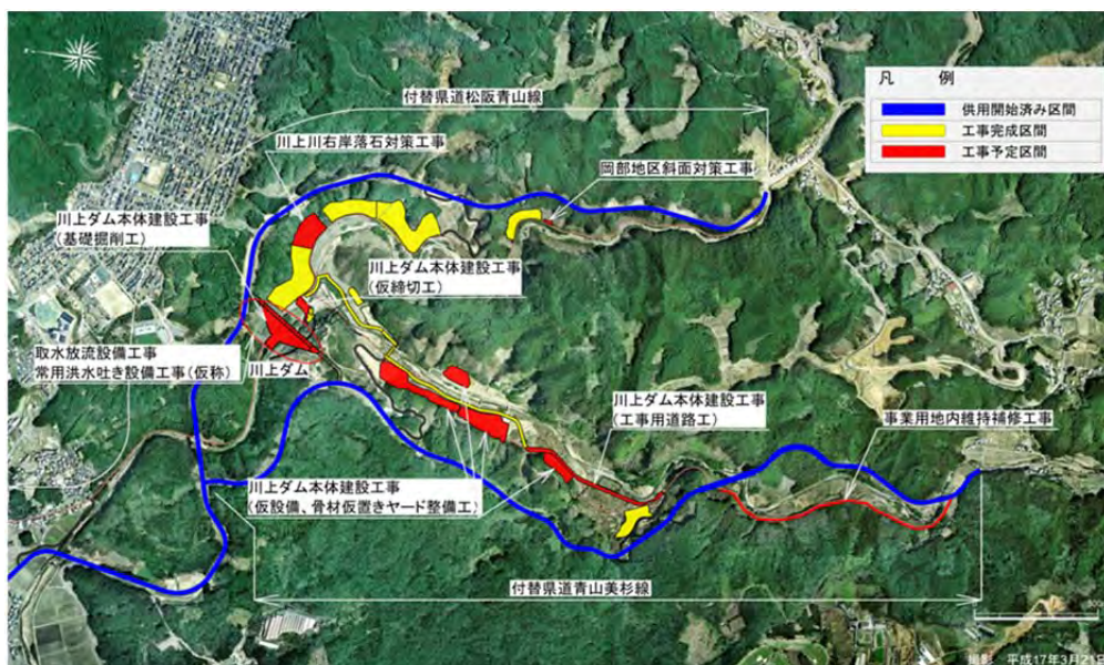
川上ダム平成30年度工事予定区間
