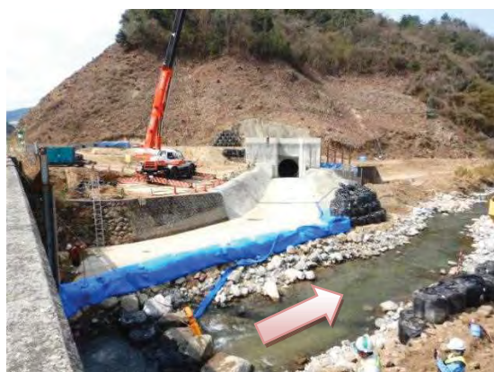
転流前の状況
