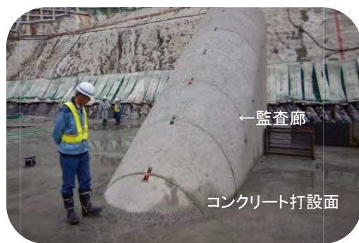
監査廊（本体の中を通る通路）の埋設状況
