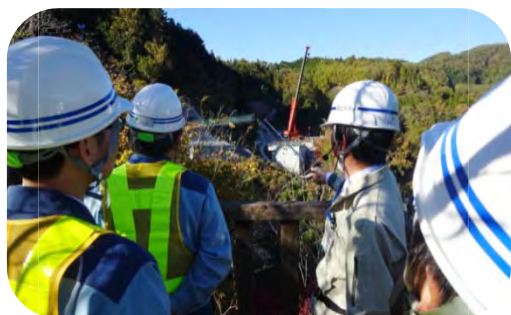
発電所の補償工事の説明を受ける
