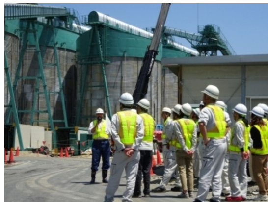
見上げる先は「骨材貯蔵設備」
